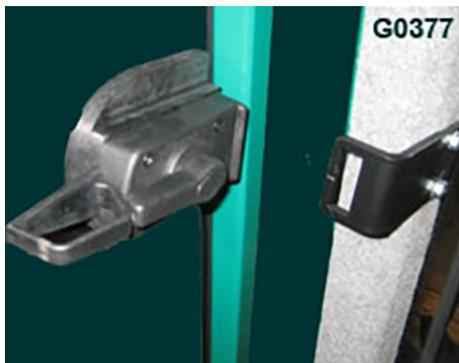
Bild 89 Schließbügel, Notausstieg
